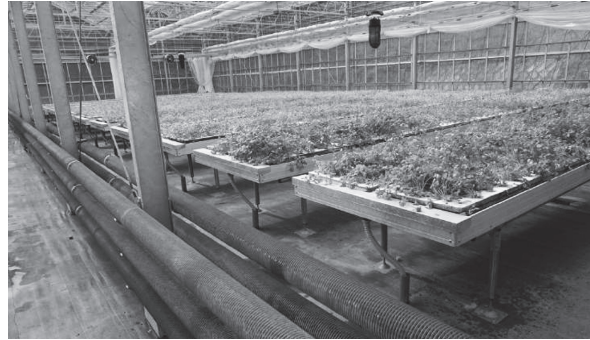
温室の中央にはパイプが通っている
